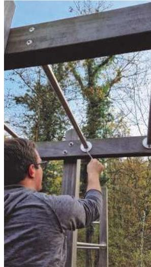
Es werden Schrauben nachgezogen, auf Beschädigungen geprüft und bei Bedarf auch repariert oder gereinigt.
